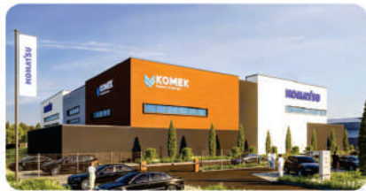
Строительство «Сервисного центра полного цикла» (Komatsu)
