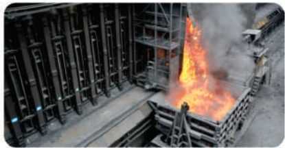
«Строительство новых коксовых батарей № 8 и 9. КХП» (АО «Qarmet»)
