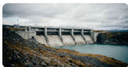
Строительство ГЭС-1,2 на реке Калжир
